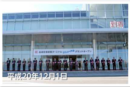
↑2年間にわたる増改築工事が完成し、リニューアルオープンしました。
