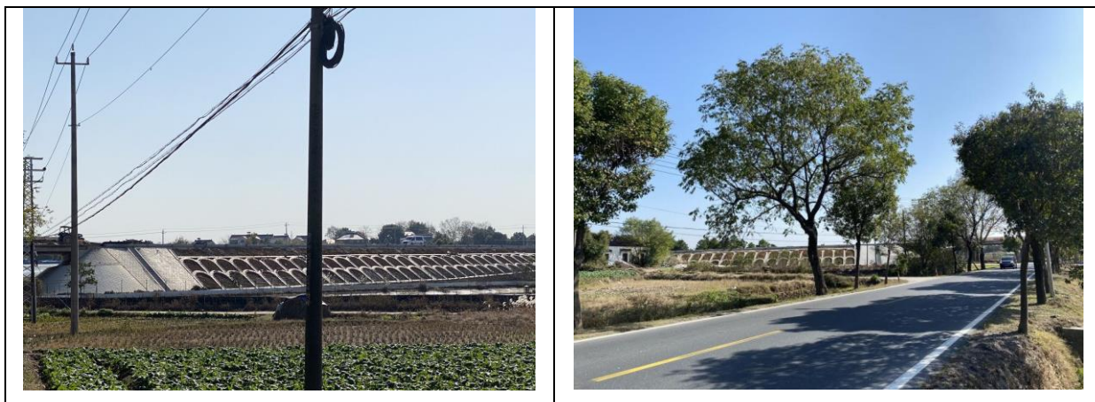
图 3.3-7 宁宣高速（在建）现状
