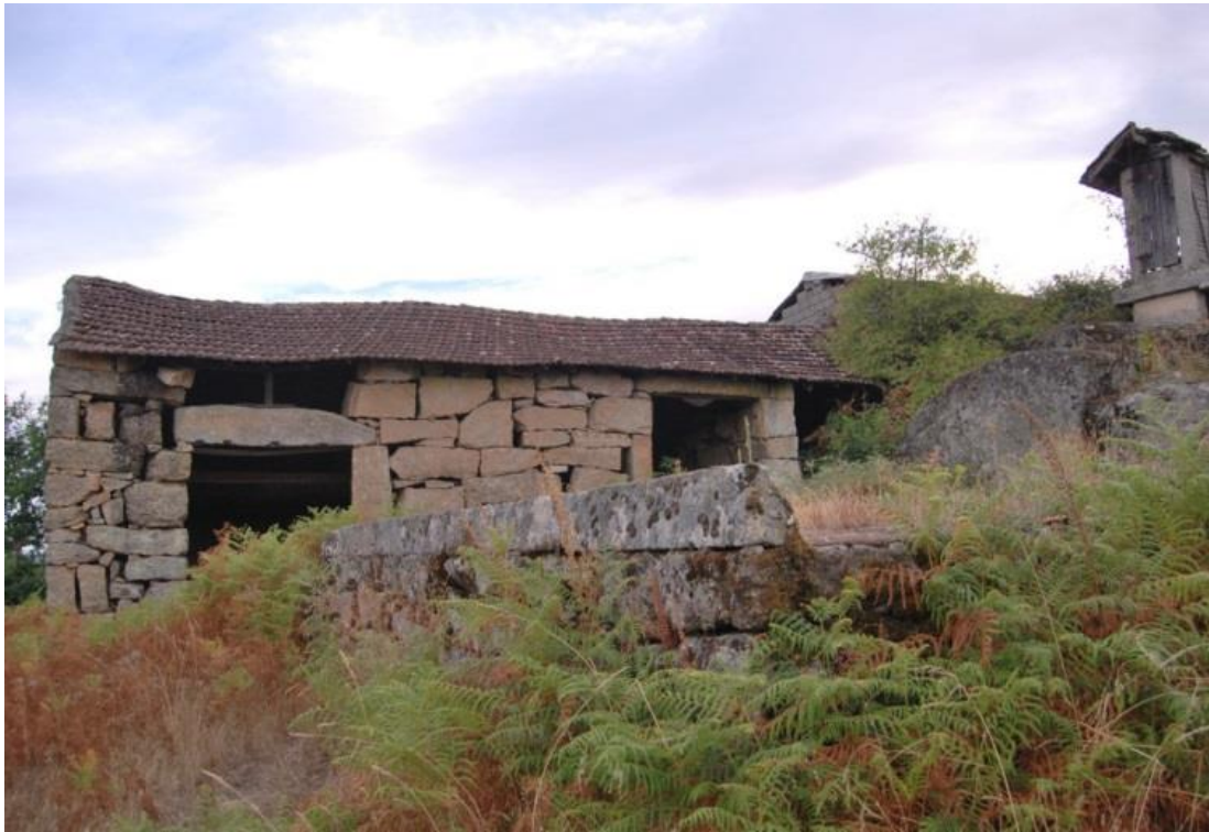
Figura 17- Vista para sul da entrada do edifício anexo ao monólito.
