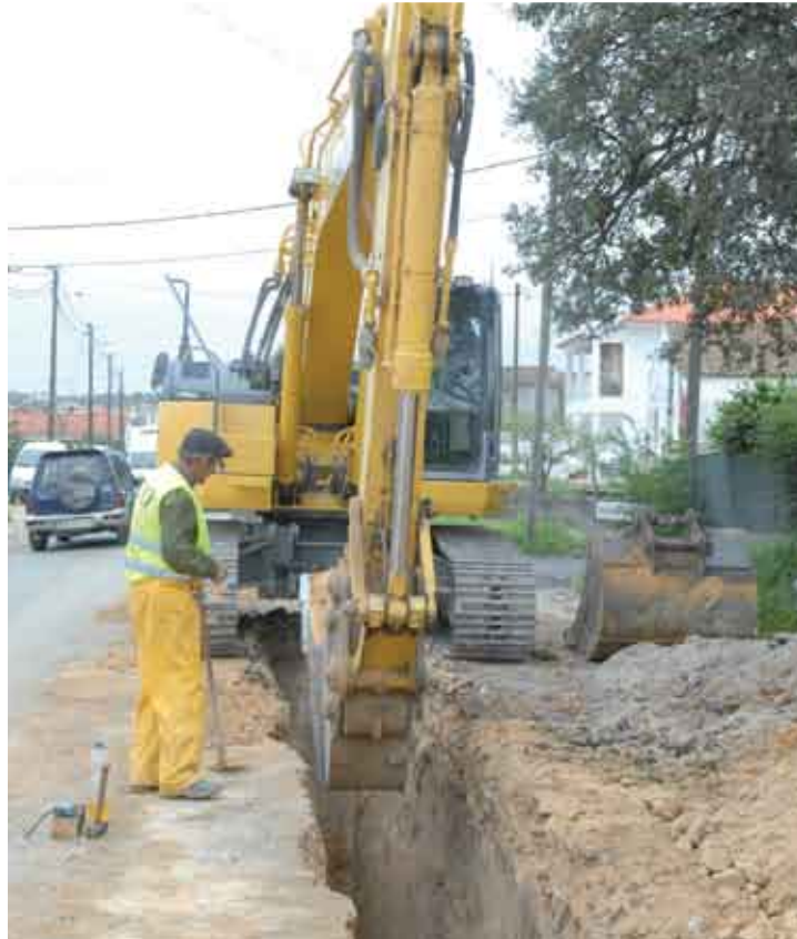
As obras incluem a colocação de 9 mil metros de colectores
