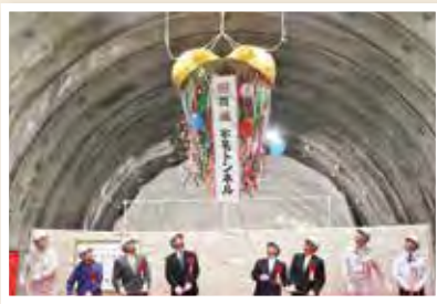
2019年 国道252号本名トンネル貫通
