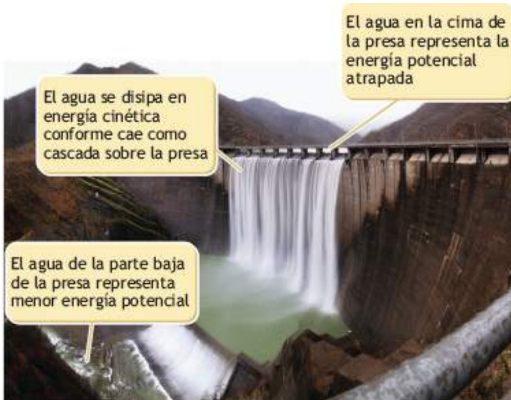
FIGURA 5.1 • La energía potencial de alto grado capaz de realizar trabajo se degrada en una forma no útil de energía cinética. En el ejemplo de la caída de agua sobre una presa, el agua en la cima, antes de que caiga como cascada al siguiente nivel, representa la energía potencial. Toda esta energía potencial se disipa en energía cinética (calor) conforme el agua choca con la superficie de abajo.
