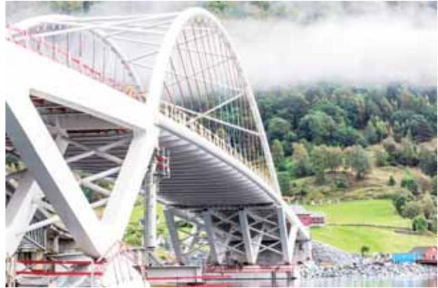
Auf der Loftenes-Brücke wurde im August der Brückenschluss betoniert.
