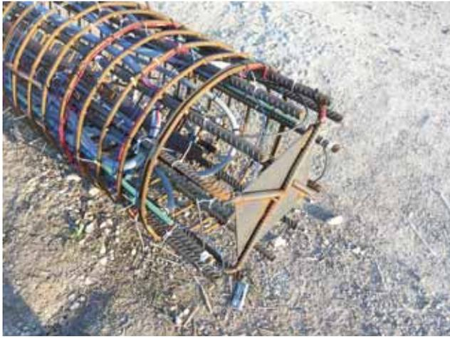
Instrumentierung am Fuß des Energiepfahls vor dem Einstellen des Bewehrungskorbes in das Bohrloch.
