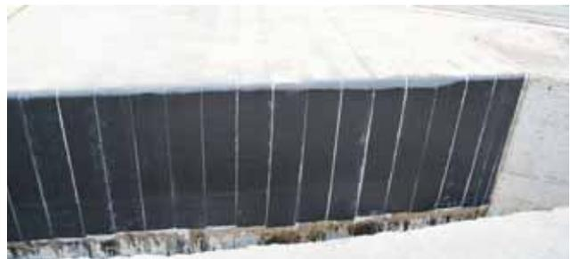
Kohlefaserverstärkte Kunststoffplatten festigen die Bestandsbrücken.
