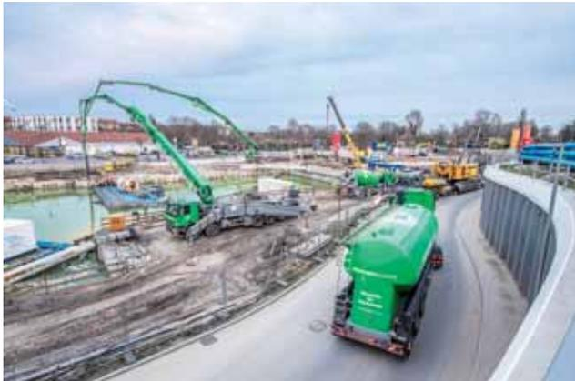
Betonieren Unterwasser: Bewährt hat sich das Contractor-Verfahren. Der Beton wird mit Hilfe einer Betonpumpe durch ein senkrecht Rohr gepumpt, das unter Wasser circa 1 m in den frischen Beton hineinreicht. Bild: HeidelbergCement Group
