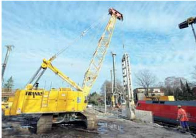
Die Herstellung der Dichtwände musste aufgrund des engen Zeitplans teilweise bei laufendem Bahnbetrieb erfolgen.
