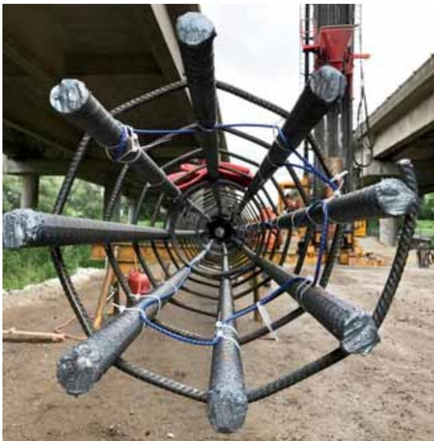
Faseroptische Sensorkabelführung am Fuß des Bewehrungskorbes für die ortsverteilte Dehnungsmessung (DSS) über den Pfahlschaft eines ATLAS-Pfahl Durchmesser 46/56.
