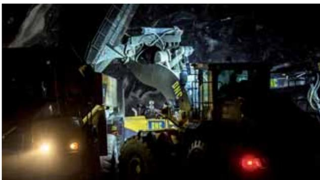
Die Schutterarbeiten werden mit Hilfe eines Radladers und knickgelenkten Muldenkippern mit 25 Kubikmeter Ladevolumen durchgeführt.
