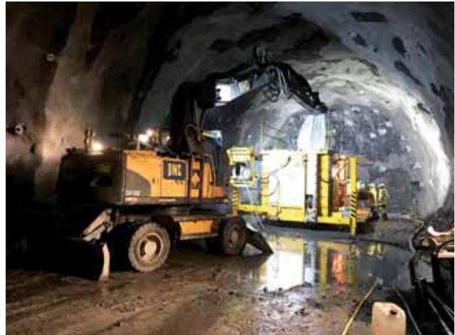
Bei erhöhtem Wasserandrang erstellt die PNC Injektionsschirme aus bis zu 40 mit Zementsuspension gefüllten Bohrungen.
