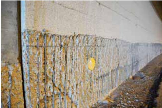
Die Hochdruckwasserstrahlung trennte den Beton ab und entfernte den Rost auf der Bewehrung.
