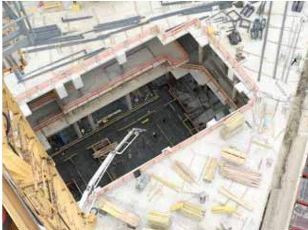
Einbringöffnung Turm A während des Betonierens mit mobiler Pumpe. Bild: PORR AG
