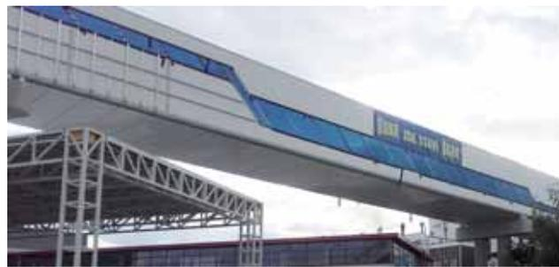
Die neue bidirektionale Paletten-Förderanlage transportiert gleichzeitig leere Verpackungen und fertige Produkte.
