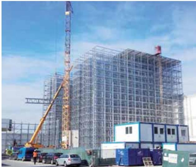
Das vollautomatische Hochregallager ist eine selbsttragende Regalraumkonstruktion aus Stahl.
