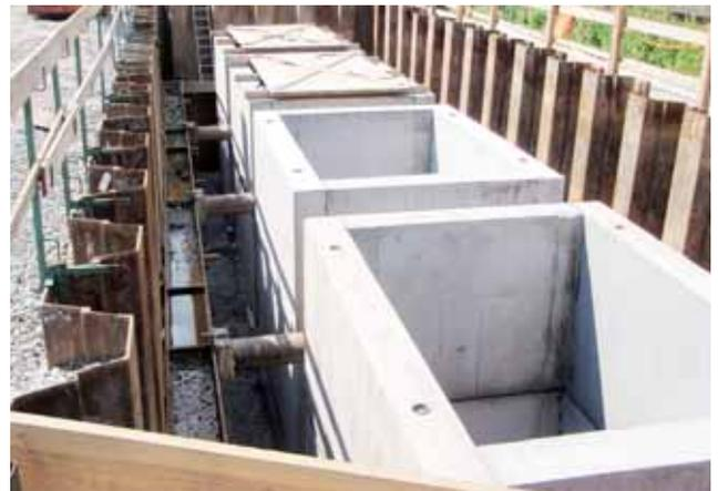
Baugrube mit versetzten Stahlbetonfertigteilen aus der Feldfabrik
