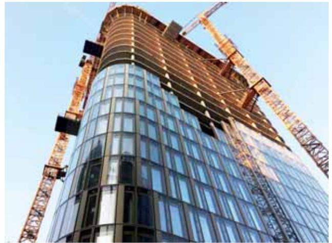
Effektives Bauen: Während die obersten Stockwerke betoniert werden, wird unten bereits die markante Außenfassade hochgezogen. Bild: Michael Meixner
