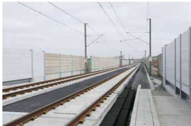
Im Auftrag von PORR war die Planung und der Einbau von Lärm- und Windschutzwänden für die Fahrgeschwindigkeit von bis zu 300 km/h.
