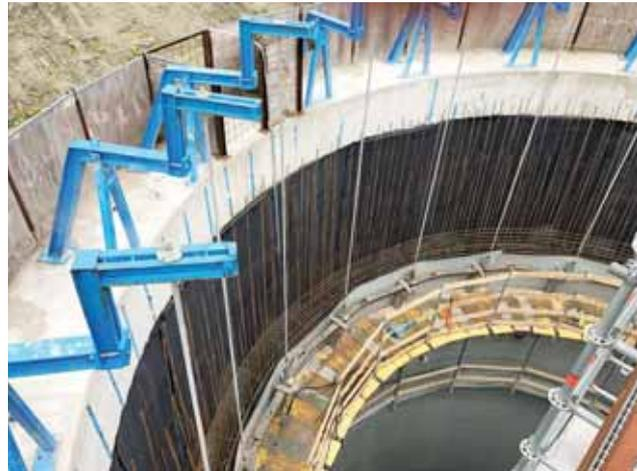
Der Aufbau der Kletterschalung zeigt die unterschiedlichen Arbeitsebenen und die Hebevorrichtung.
