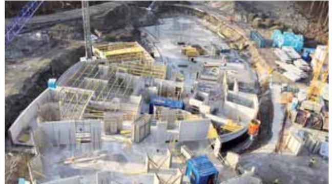
Durch die kurze Rohbauzeit und die komplexe Geometrie des Gebäudes kommen sowohl Fertig- als auch Halbfertigteile zum Einsatz.
