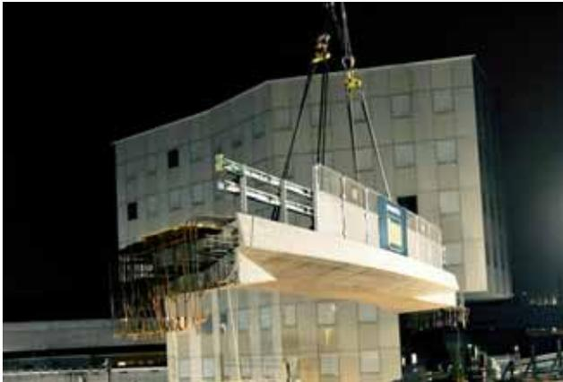
Bei der Positionierung der 170 t schweren Platten war höchste Präzision gefragt.
