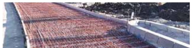
Die installierte Fahrbahnheizung vor dem Betonieren.
