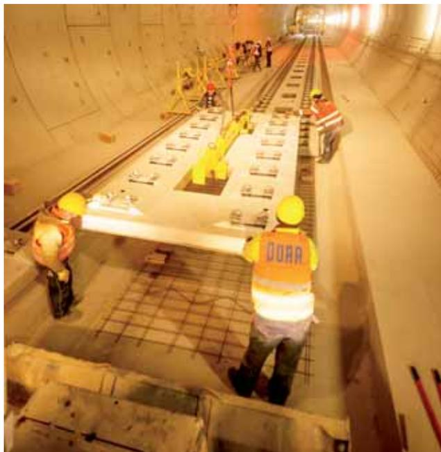
Verlegung von PORR Gleistragplatten auf engstem Raum.
