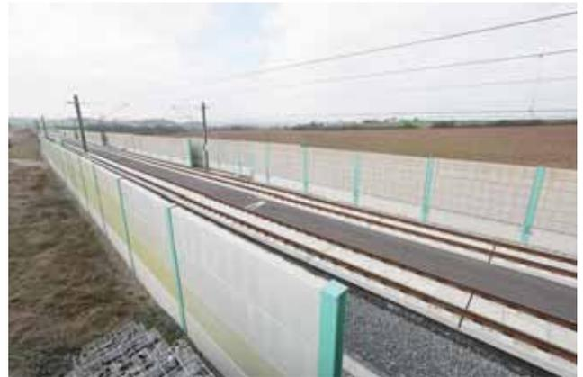
Bei insgesamt drei Teilabschnitten der neuen VDE 8 Hochgeschwindigkeitsstrecke kam das Slab Track Austria System der PORR zum Einsatz.
