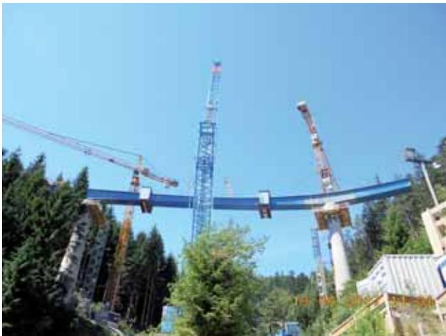
Einhub Nr. 4 mit Stahlbauschuss 6 und 7 mit 63 t. Die Montage der
