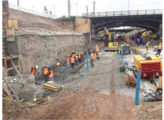
Oft waren mehrere Gewerke zur selben Zeit und am selben Ort im Einsatz. So erfolgte etwa das Abstemmen der Bohrpfähle gleichzeitig und auf engstem Raum mit dem Erdbau-, Ingenieurbau- und Wasserhaltungsarbeiten.
