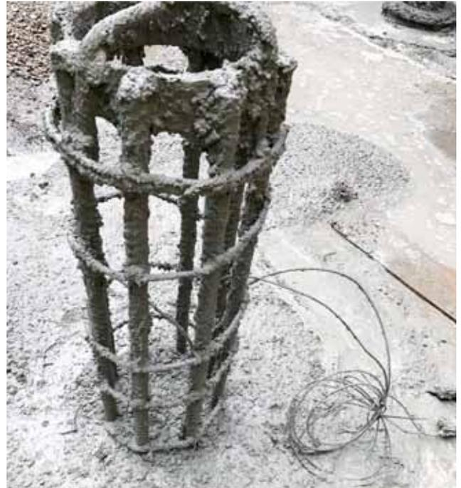
Feuchtigkeit, Schlamm und Frischbeton – die schwierigen aber üblichen Randbedingungen des Spezialtiefbaus – Pfahlkopf eines ATLAS-Pfahl Durchmesser 46/56 nach der Pfahlherstellung.
