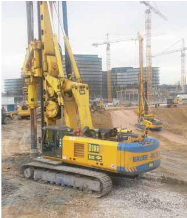
Bis zu drei Drehbohrgeräte waren im Einsatz, um die Fundierungspfähle und Hilfsstützen für die Lagerung des zukünftigen Deckels herzustellen.
