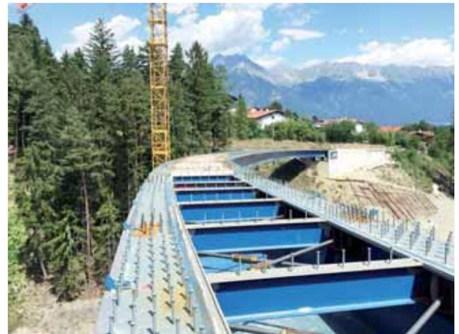
Stahltragwerk vor Herstellung der Verbundplatte.
