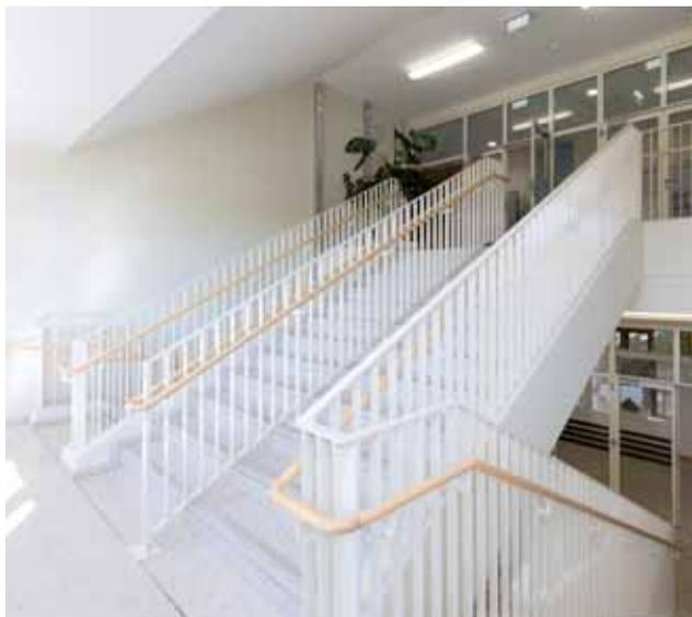
Im Rahmen der Verbesserung des Brandschutzniveaus errichtete die PORR zwei zusätzliche Fluchtstiegenhäuser.
