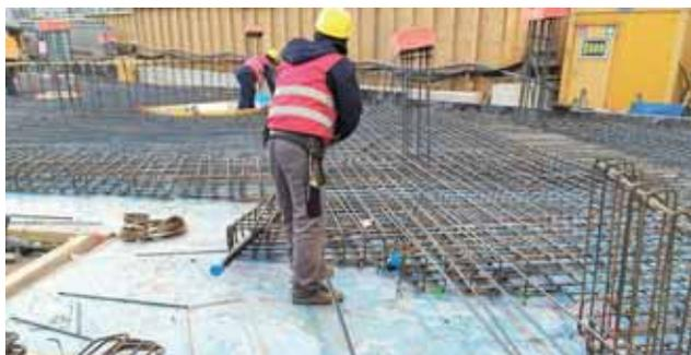
Herstellung des ersten Deckels, der Decke über dem ersten Untergeschoss.
