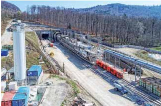
Aufbau der Tunnelvortriebsmaschine „Käthchen“ vor dem Portal des Boßlertunnels – Weströhre.
