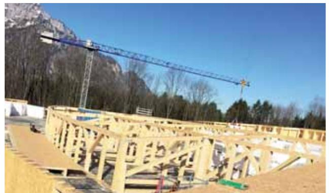
Die Aufständering des Dachstuhls mit vorgefertigten Holzriegelwänden.
