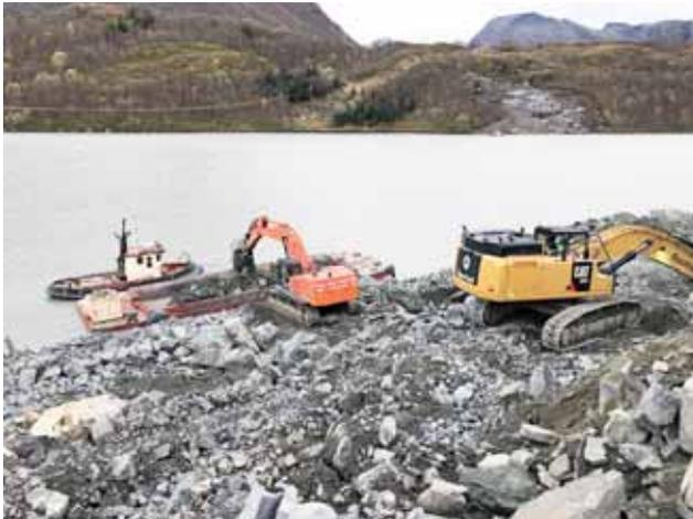
Bei den Arbeiten im See kamen Barger und Klappschuten zum Einsatz.
