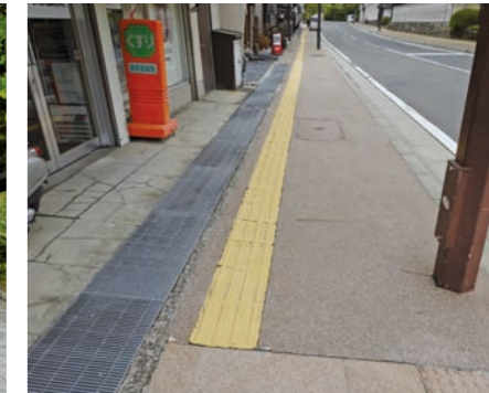
点字ブロック
