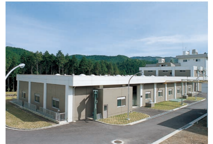
高野山下水処理場
