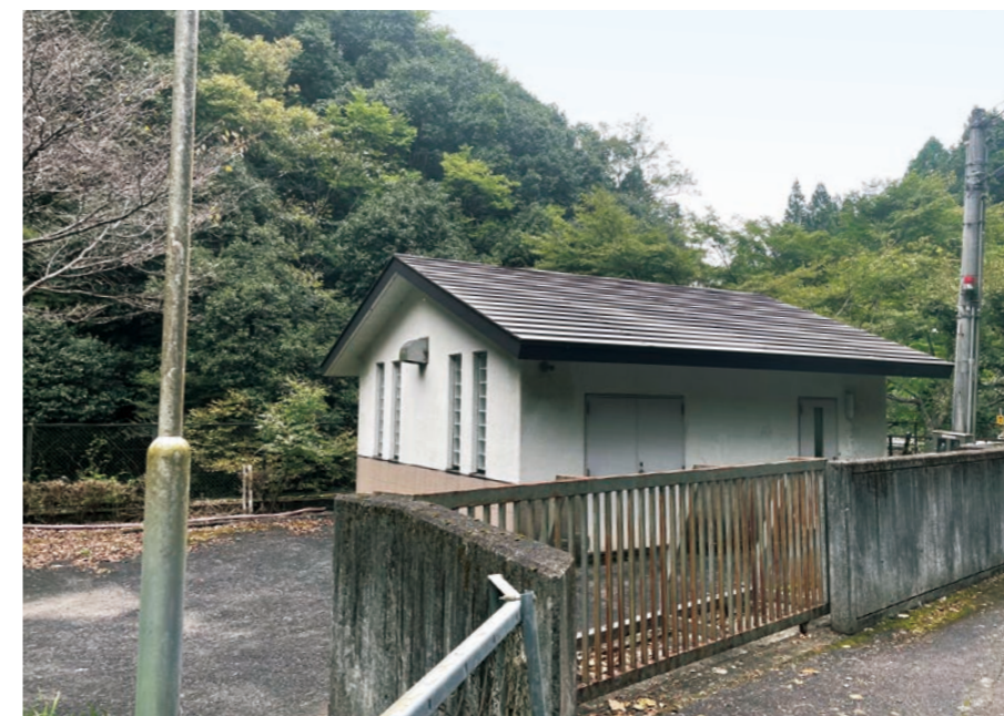
不動谷浄化センター
