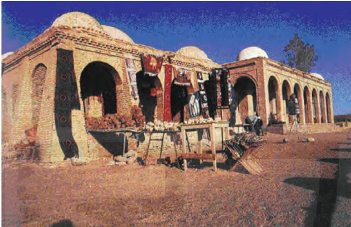
Gambar 7.10 Bangunan Padang Pasir, struktur ber dinding masif, atap kubah dengan bukaan-bukaan kecil, warna coklat
