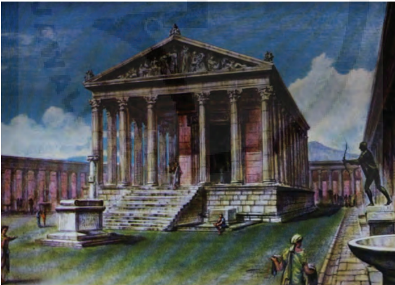
Gambar kuil Apollo sebelum gempa bumi dengan podium tinggi dan pronaos di dalam, jarak kolom di tengah lebih besar, di depannya terdapat altar marmmer, di sekelilingnya portico.
