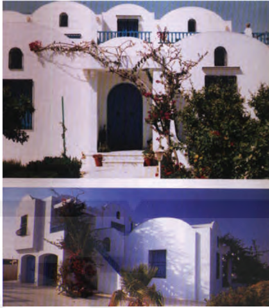
Gambar 7.8 Bangunan vila, bangunan masif dengan bukaan-bukaan kecil, berjendela kecil rangkap, atap lengkung/kubah
