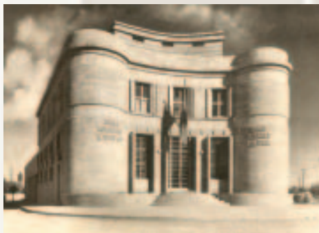
Foto e Degës së Bankës Korçë.
