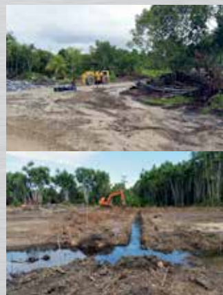
PPKS Mukah earthwork
