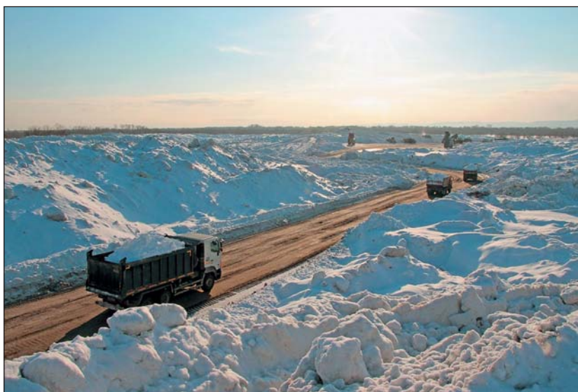
Полигоны «Северный» (вверху) и «Южный» во второй декаде января 2018 г.
