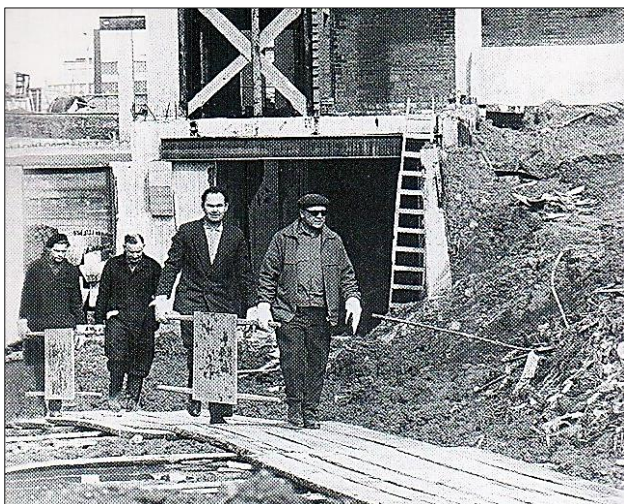
На строительстве будущего корпуса НИИ «Полюс».
