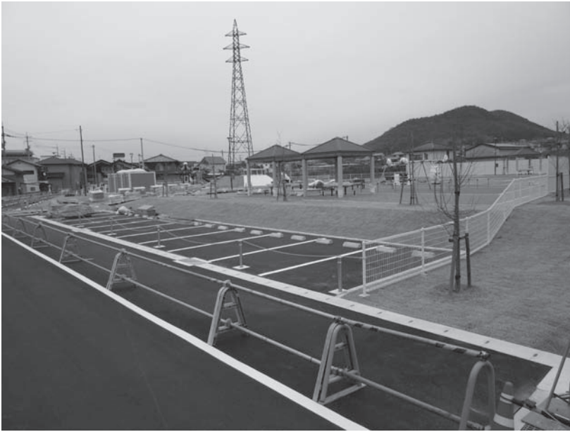
工事途中のひだまり公園あやがわ（通称「ヤドン公園」）
