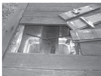
綾上小学校ウッドデッキ
