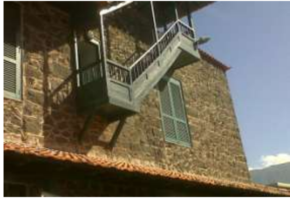
Imagen 28. Escalera que lleva a la azotea. Uno de los elementos de arquitectura canaria que posee la casa.
