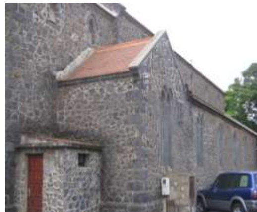
Imagen 34. Lateral de la Iglesia, con una pequeña habitación anexa.
