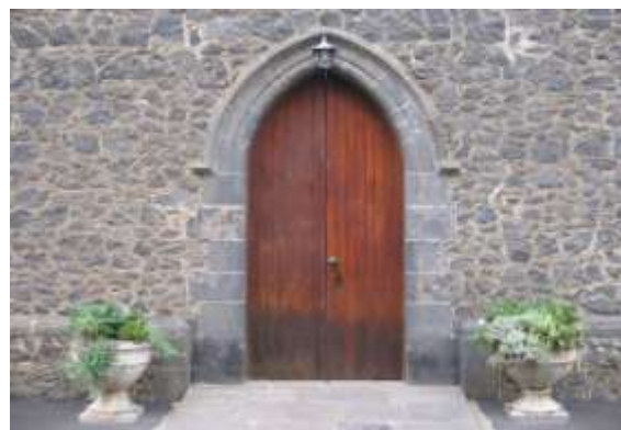
Imagen 35. Puerta de acceso lateral a la Iglesia.
