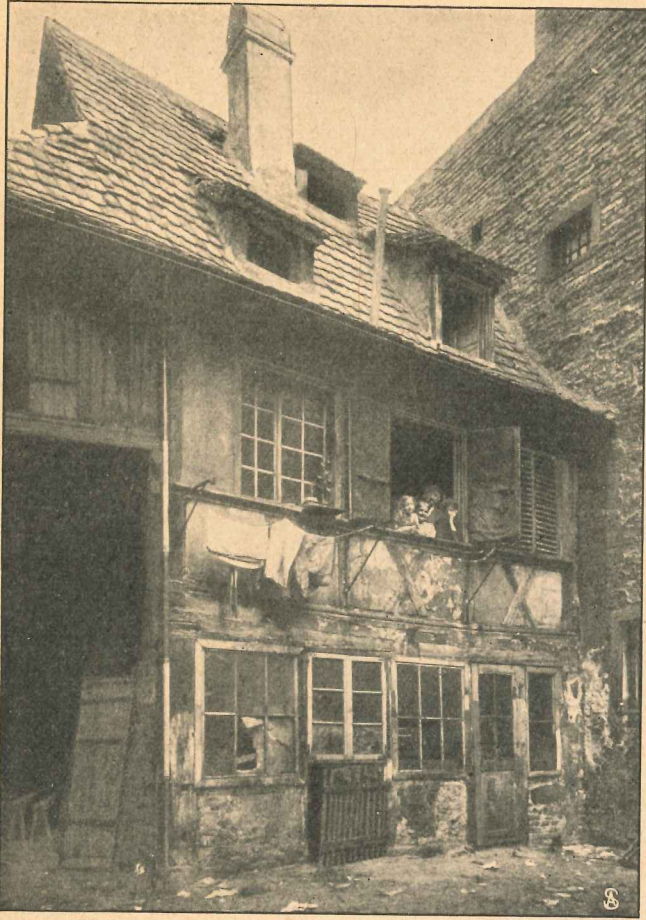
Hinterhaus in der Großen Stadelgasse vor dem Abbruch.
