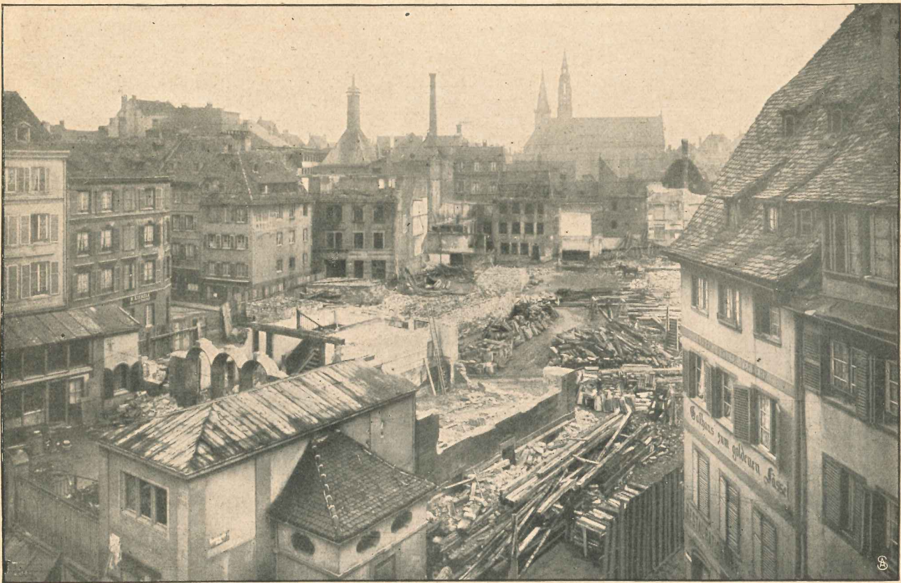
Gerbergrabenplatz während des Abbruchs.
