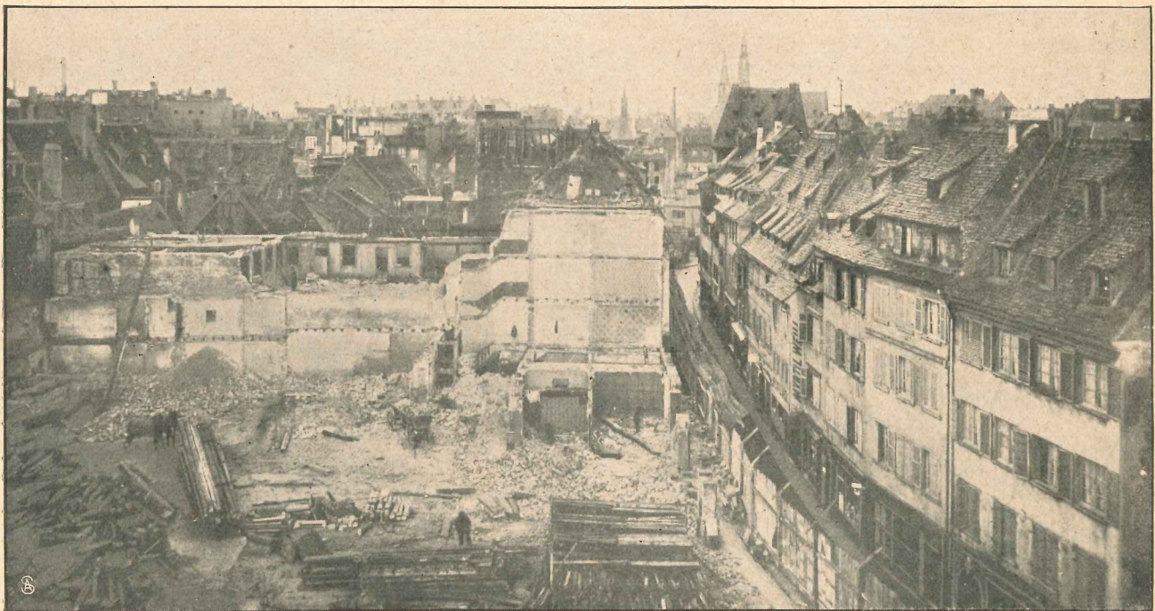
Die Barbaragasse während des Abbruchs.
