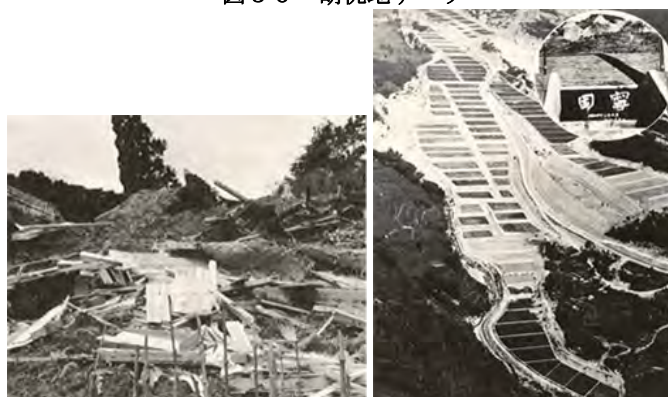
左：発生直後、右：復旧後
