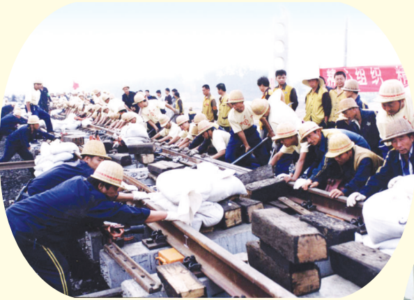
西安铁路分局更换提速道 岔施工现场
