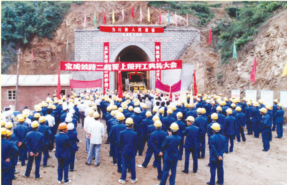
1993年7月13日，宝(鸡)成(都)铁路二线阳上段建设开工
