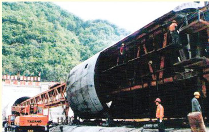
国家重点项目秦岭隧道施工中首次使用的全断面掘进机
