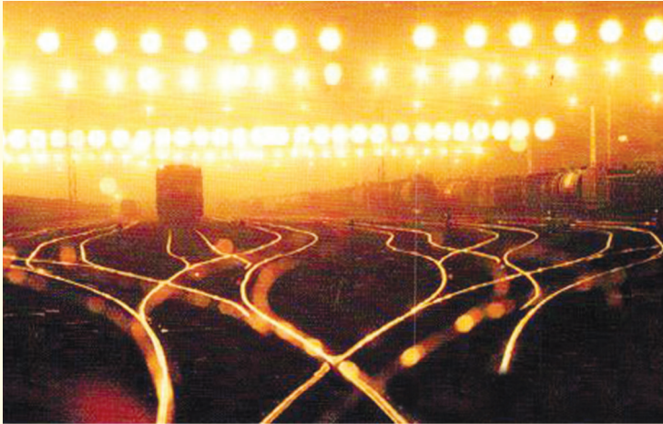
2000年9月，安康东站编组场扩建工程验收开通
