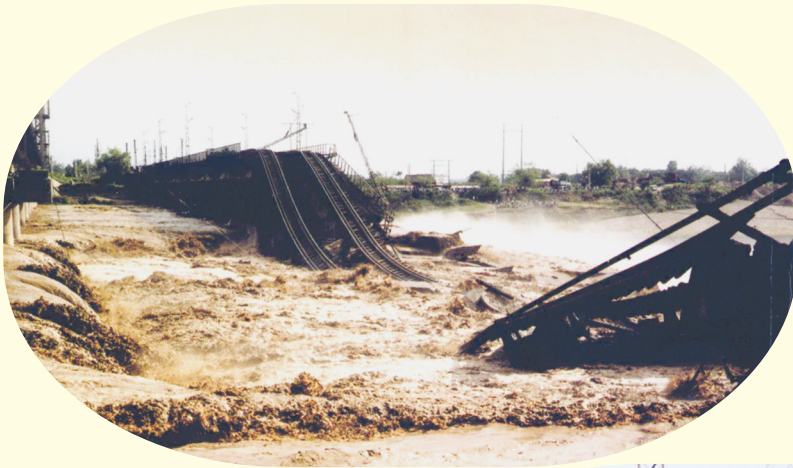
2002年6月9日，陇海线灞河铁路大桥被洪水冲塌，陇海线行车中断
