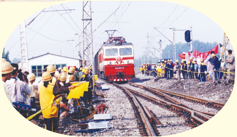
2002年6月17日，1061线路所利用西康线灞河大桥，在陇海线1061公里处接通陇海下行线与田灞联络线，陇海线行车恢复
