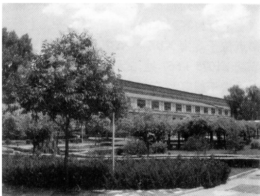
西东车辆段检修库一角
