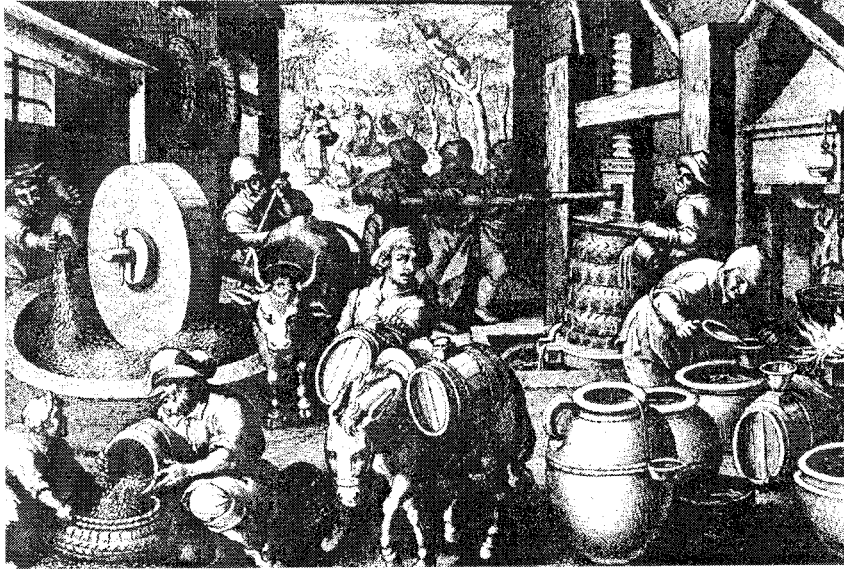
Olieslagerij met rosmolen (hier door een os aangedreven).
