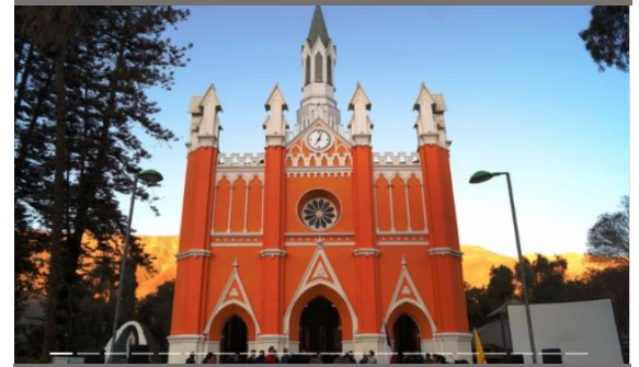
Ex - estación de Tierra Amarilla
