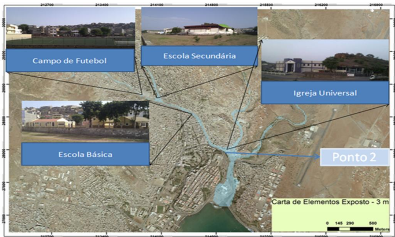
Figura 31 – Carta de Risco de Algumas Infra-estruturas Colectivas com subida de 3 metros
