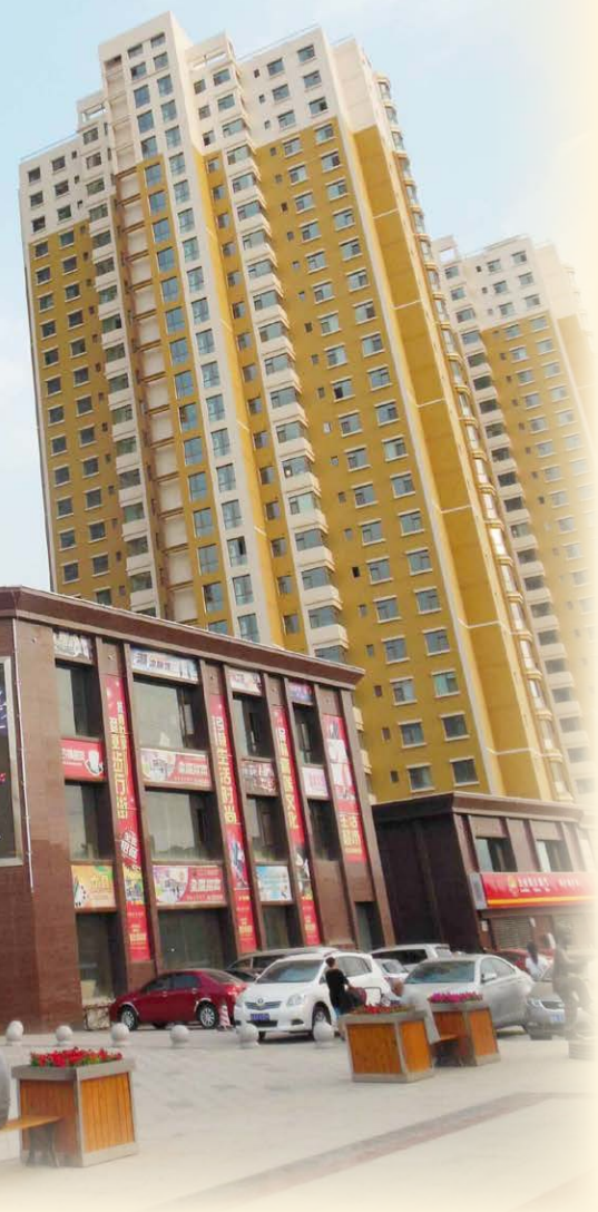
2009年建成的中和·教育世家住宅小区
