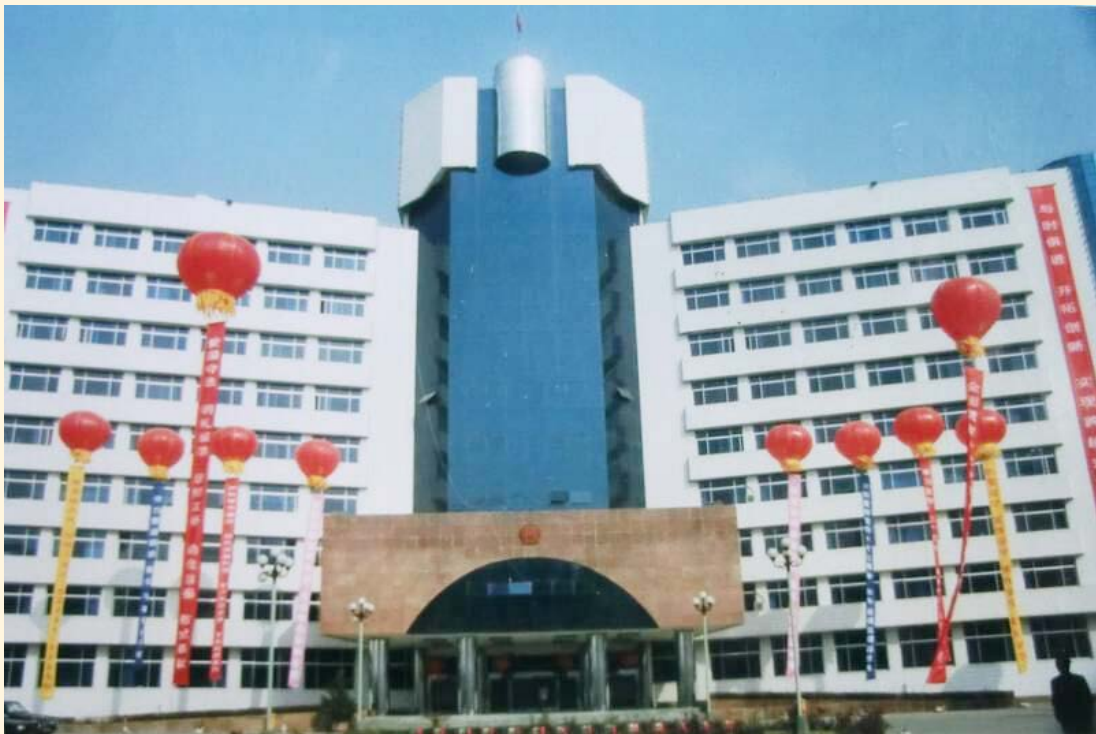
1995 年建成的安宁区委、区政府办公楼
