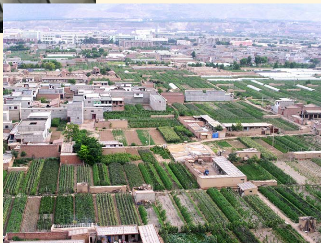
安宁区吊场乡农村田园 (2004年摄)
