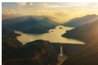
Hydropower Plant Đakđrinh (Quang Ngai)
