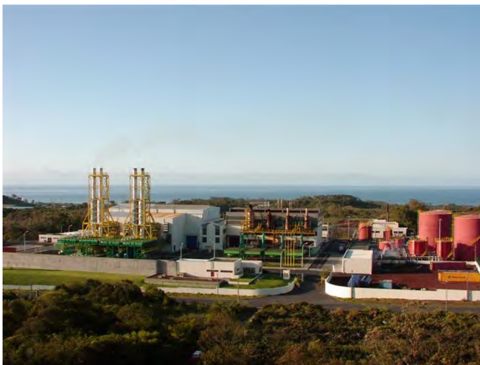
Figura 5 - Aspecto geral da Central do Caldeirão
