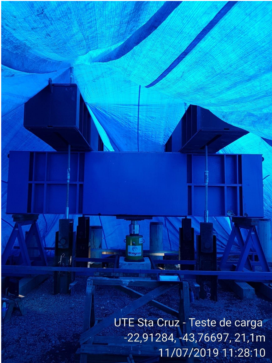
Estaqueamento - Teste de carga
