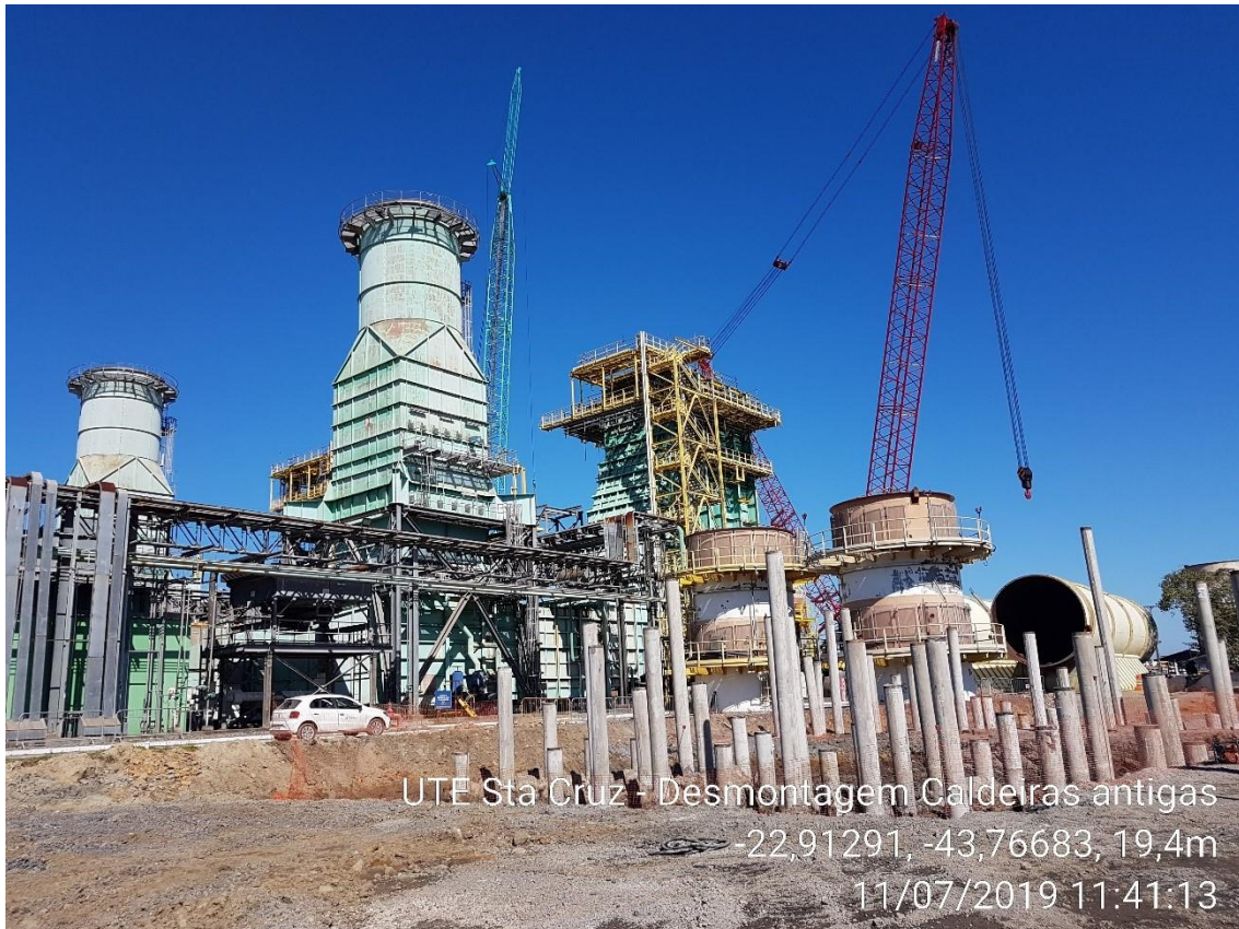
Descomissionamento (desmontagem) das duas Caldeiras de Recuperação antigas
