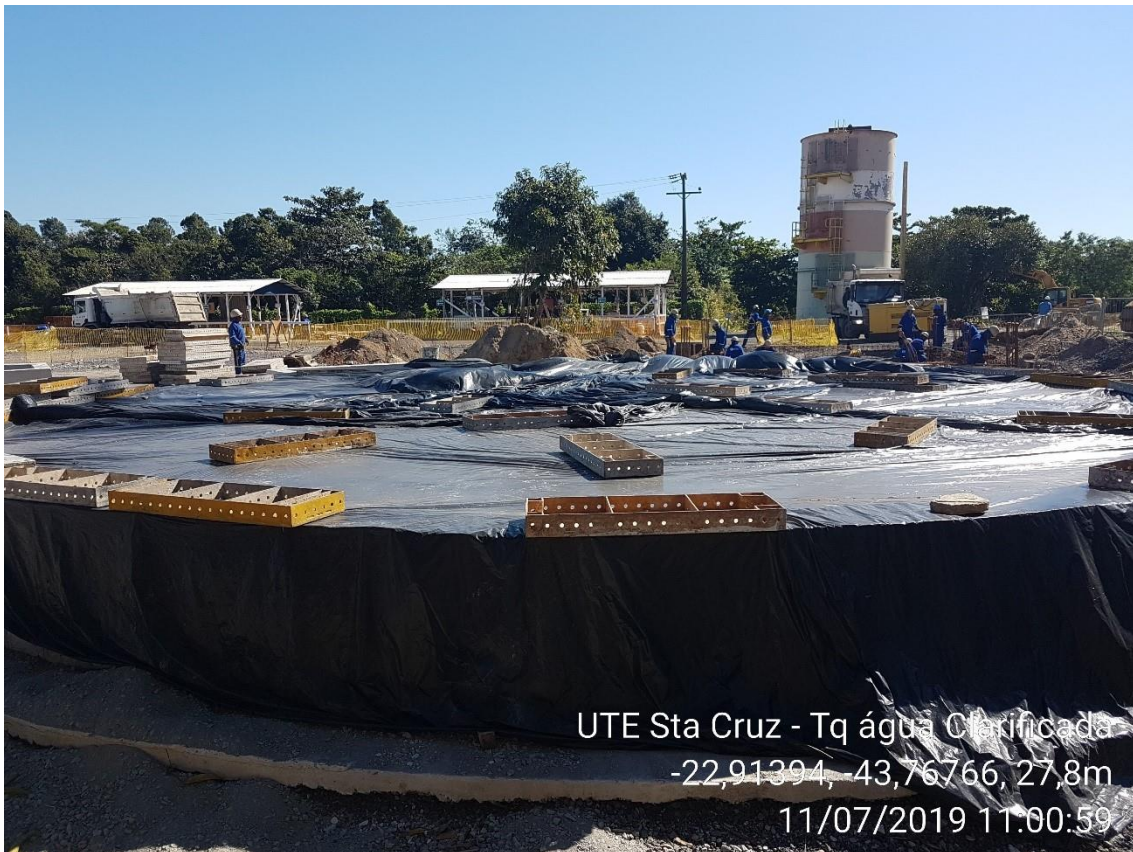
Fundações - Tanque de Água Clarificada
