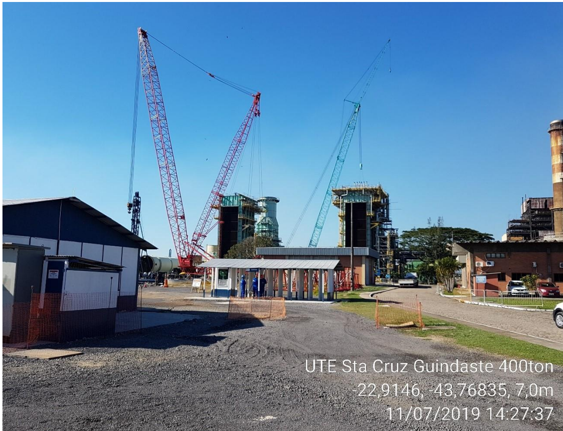
Descomissionamento (desmontagem) das duas Caldeiras de Recuperação antigas
