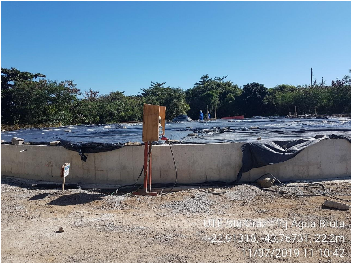
Fundações - Tanque de Água Bruta
