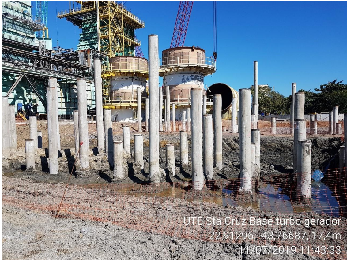
Estaqueamento - Base do Turbogenerador a Vapor
