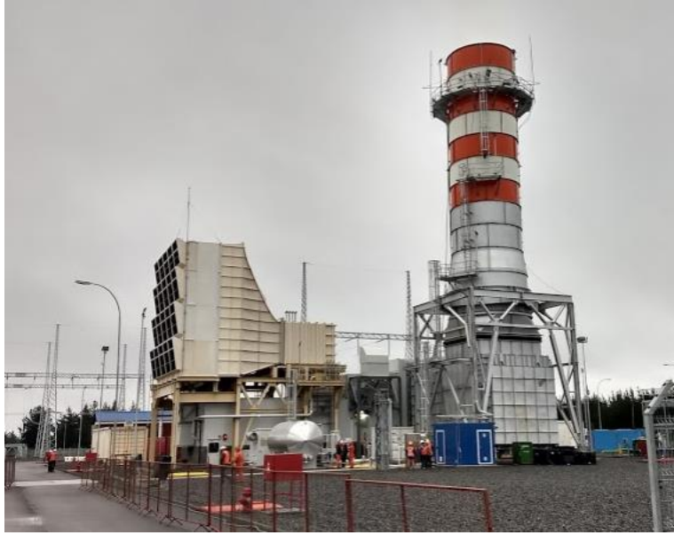
Figura 1: Central Los Guindos, vista general Unidad 02
