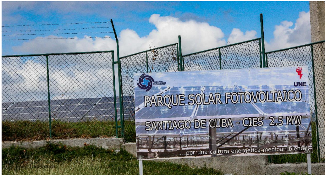
Solar power plant, Abel Santamaría, Santiago de Cuba
