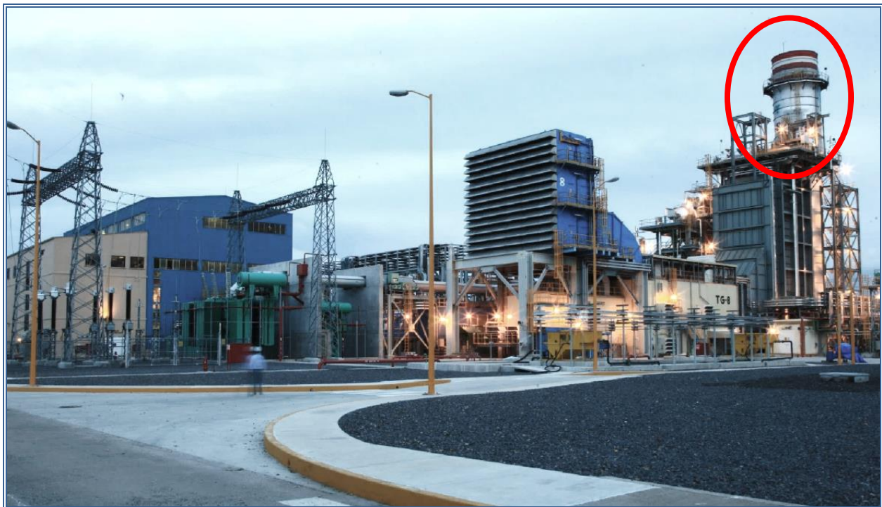
Figura 20. Chimenea de una planta de generación eléctrica de tipo auto-soportada sin tirantes
