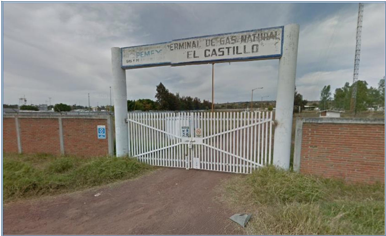
Figura 10. Entrada a la estación.
