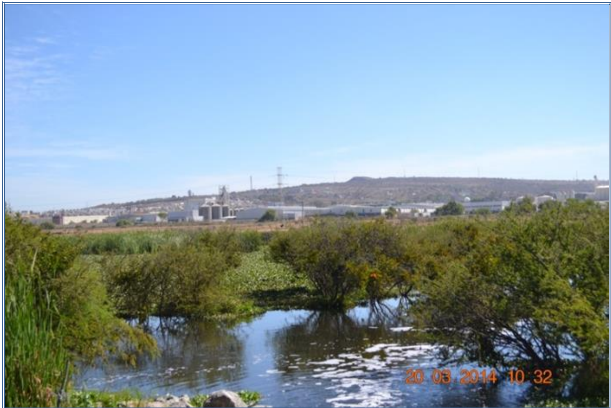
Figura 61. Vista hacia el Este de la presa El Ahogado.
