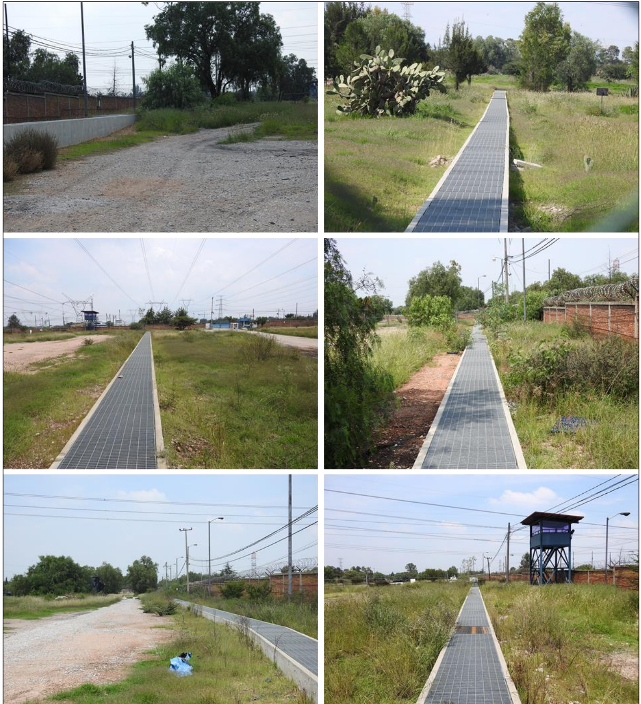
Figura VIII.6-2. Condición general de la trayectoria del ramal interno de gas natural que alimentará al Proyecto (corre paralelo a la línea de gas actual del lado contrario a la barda)
