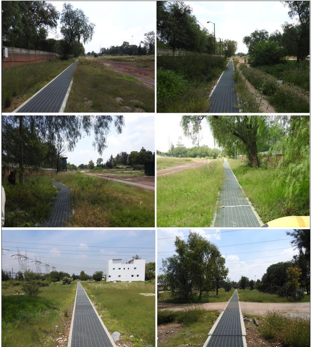
Figura VIII.6-1. Condición general de la trayectoria del ramal interno de gas natural que alimentará al Proyecto (corre paralelo a la línea de gas actual del lado contrario a la barda)
