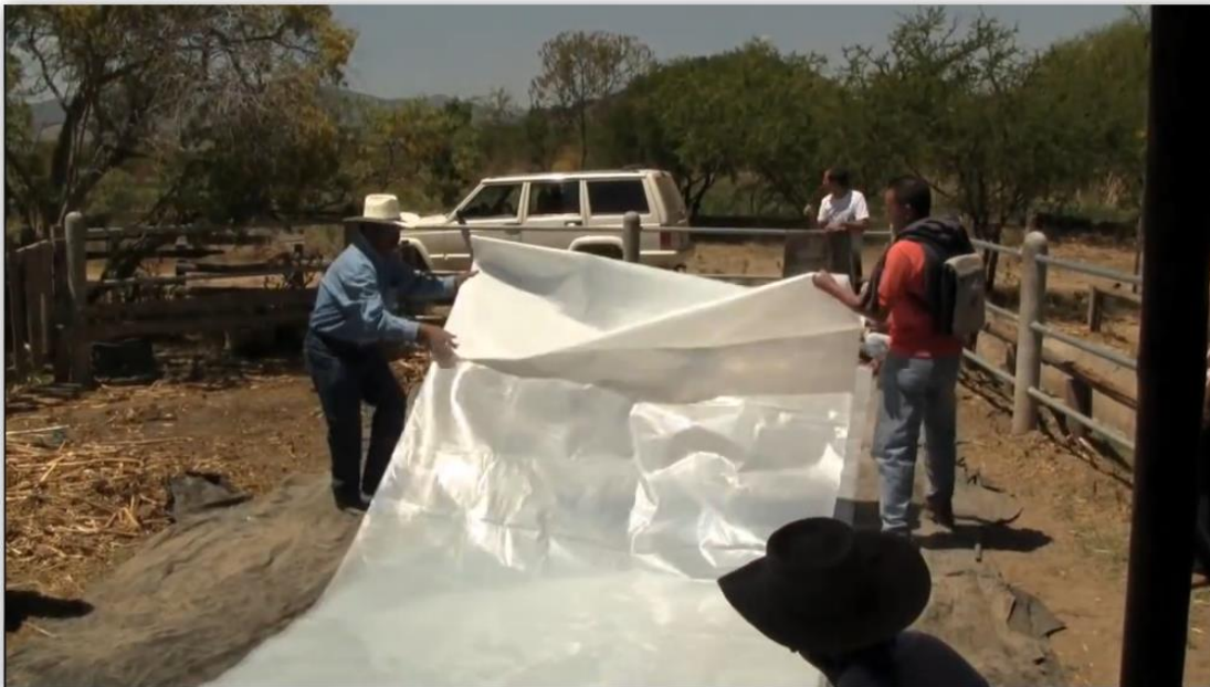
Figura 63: Despliegue de segunda capa de plástico.
