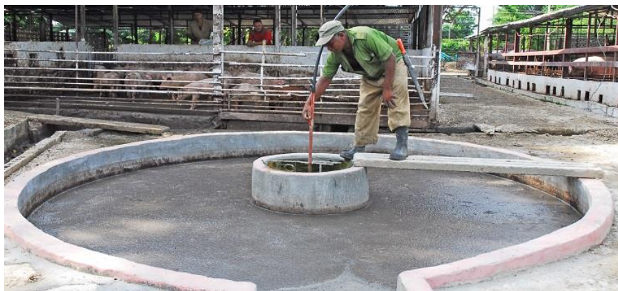
Figura 53: Biodigestor de cúpula fija
