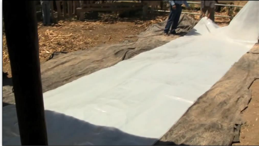
Figura 66: Proceso de remoción de pliegues en la bolsa.
