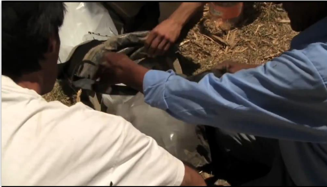
Figura 73: Amarre de la bolsa a la tubería de PVC.
