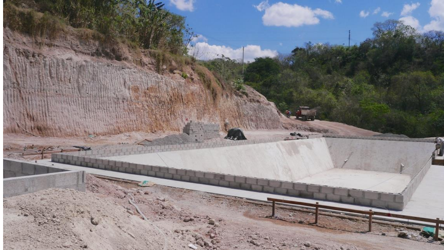
Figura 51: Construcción de tanque de descarga de materiales.
