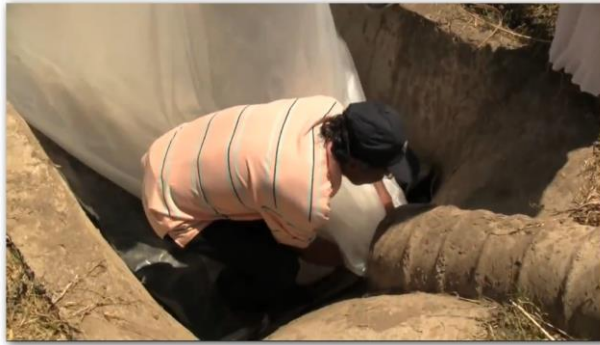
Figura 70: Introducción de la bolsa en la tubería proveniente del tanque de mezcla.
