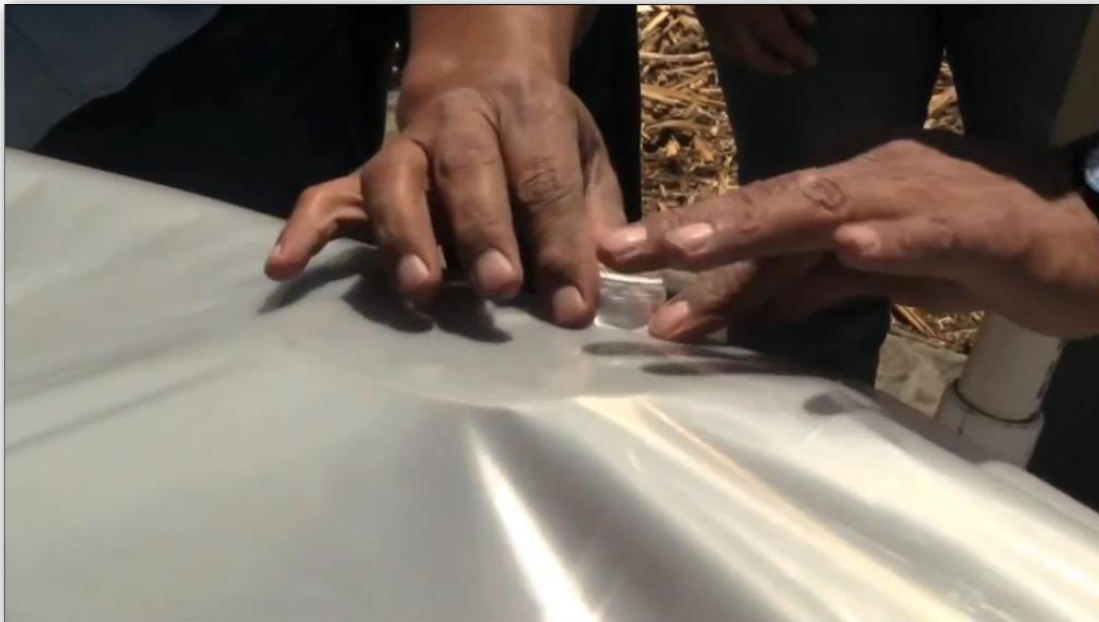
Figura 67: Colocación del acople PVC.
