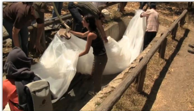
Figura 69: Colocación de biodigestor en la zanja de retención
