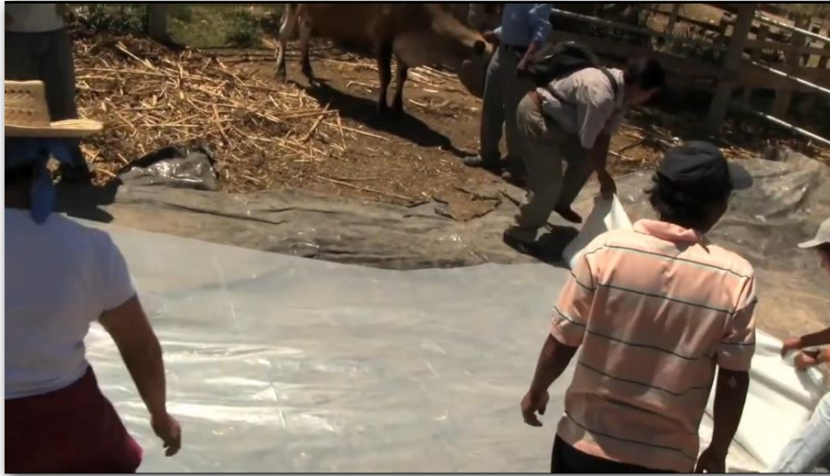
Figura 62: Extendido de plástico primera capa.
