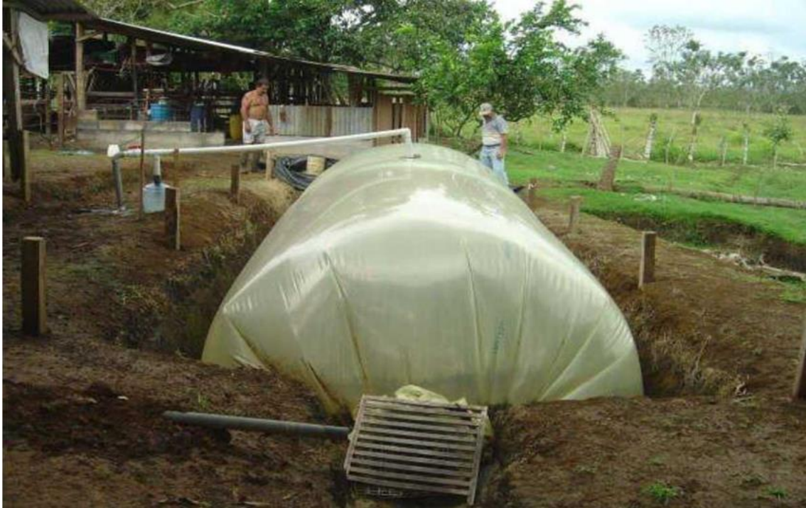
Figura 47: Biodigestor tipo balón construido en doble bolsa de polietileno de bajo costo.
