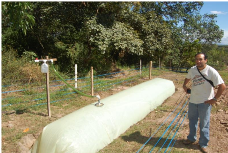
Figura 55: Biodigestor de estructura flexible sin protección solar como protección contra impactos.
