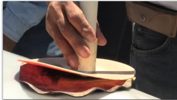
Figura 68: Colocación de empaques de seguridad.
