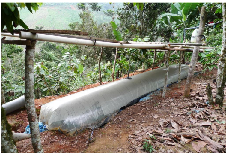
Figura 57: Construcción de biodigestor de estructura flexible con techo protector.
