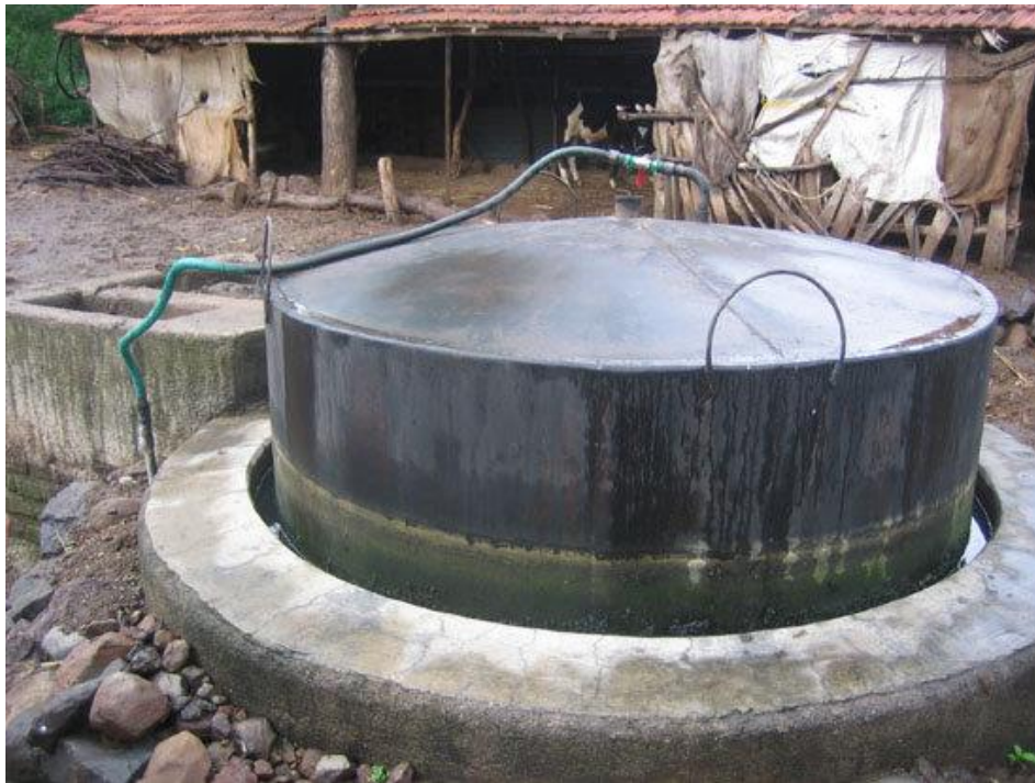
Figura 54: Biodigestor de cúpula móvil se pueden observar los agarraderos que facilitan el proceso.
