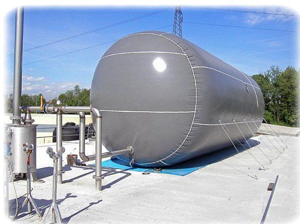
Figura 49: Gasómetro tipo balón.
