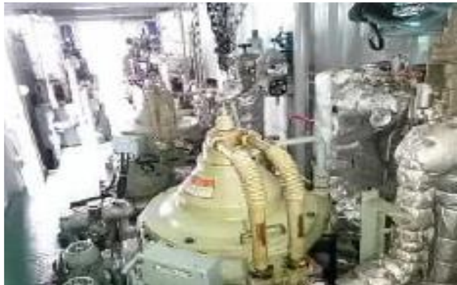
Imagen No 18. Bombas de alimentación
