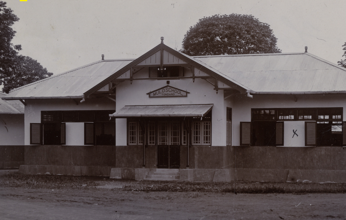
Hoofdingang van de MULO-school te Tondano Sumber : digitalcollections.universiteitleiden.nl
