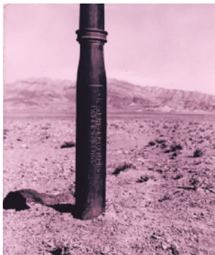
Fuß eines fast 100jährigen eisernen Mastes der Indolinie in Persien, 1966.
