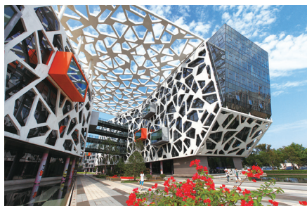
阿里巴巴（中国）有限公司大楼 (区发改局 提供)
