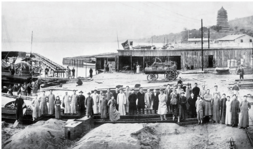
钱塘江大桥开工典礼（钱塘江大桥纪念馆 提供）
