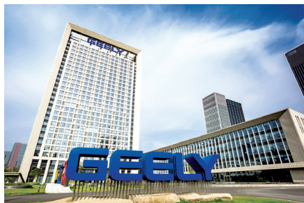
浙江吉利控股集团有限公司大楼 (区发改局 提供)
