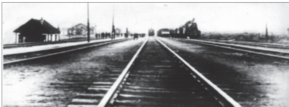
Железнодорожные пути на станции Кочмес
