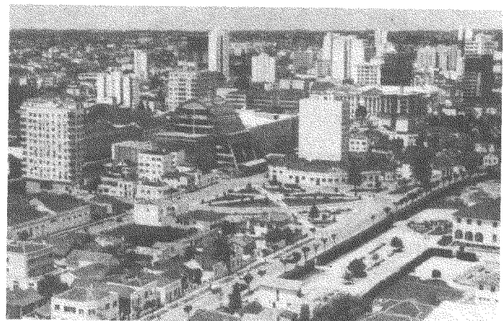
Vista parcial aérea da cidade
