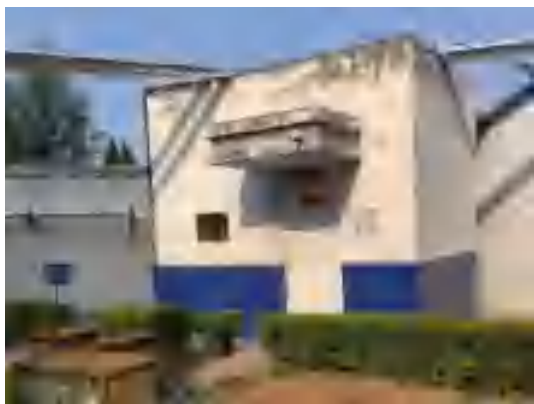
生活污水处理站（生活区）
