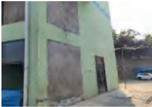
矿井水处理站（生活区）
