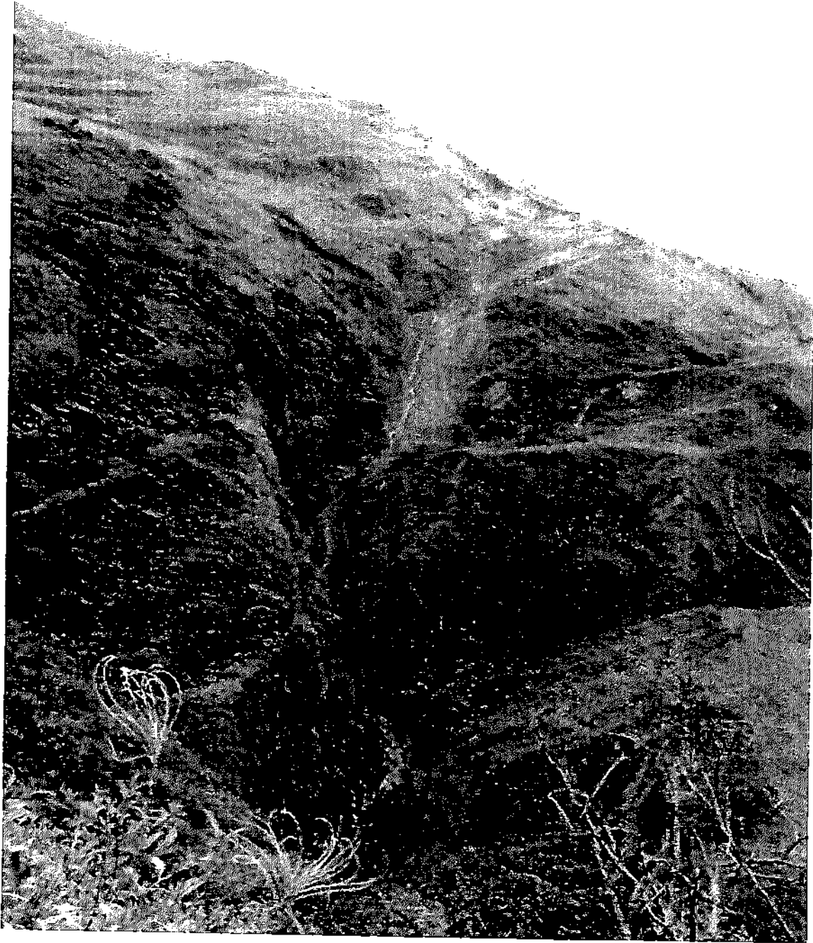
FOTO N° 01 : El relieve muestra que en esta zona los huaycos tienen una larga historia, tan pronto llueve se desprende parte de los cerros y baja hasta el río Utcubamba, en cuya confluencia afecta a la carretera Bagua-Pedro Ruiz-Chachapoyas, en esa confluencia está prevista la ubicación de la bocatoma de la proyectada hidroeléctrica Utcubamba I. En la fecha 04-02-2015 el Gobierno Regional Amazonas prohibió la salida de ómnibus de Chachapoyas a Bagua-Chiclayo, por el corte de la carretera que hizo este huayco.
