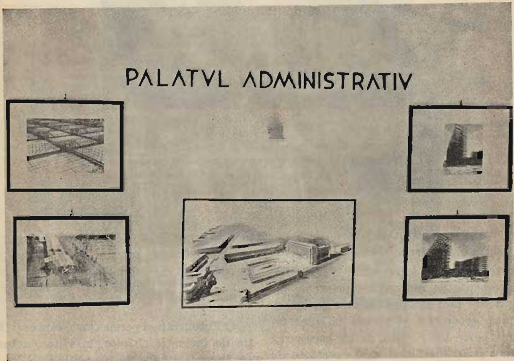
Direcțiunea de Studii C.F.R. Câteva aspecte ale lucrărilor noului Palat Administrativ C.F.R.
