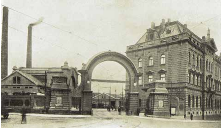
Elektrárna v Praze-Holšovicích byla nejen dílem ryzem technickým, ale i architektonicky zajímavým. Dodnes existující části jsou památkově chráněny, nicméně impozantní vjezd do areálu, za nímž jde vidět hala tramvajové vozovny Elektrických podniků, je již minulostí. Repro z časopisu Český svět
