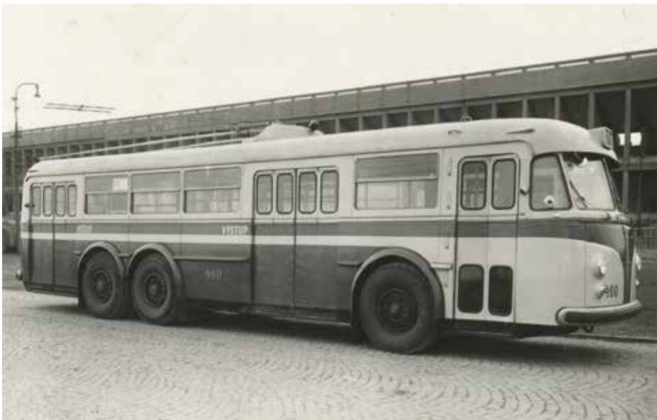
Poslední dodaný trolejbus Tatra 400 ev. č. 460 byl dokončen v roce 1955. Na první pohled se odlišoval především dvojicí klaksonů situovanou pod čelními reflektory, vylepšení však bylo na voze více, ať již v elektrické či mechanické části. Některé z aplikovaných prvků se ale ukázaly nevhodné (například celosvařovaná střecha) a trolejbus byl později do značné míry sjednocen se sériovými vozy. Sběrka: Archiv DPP
