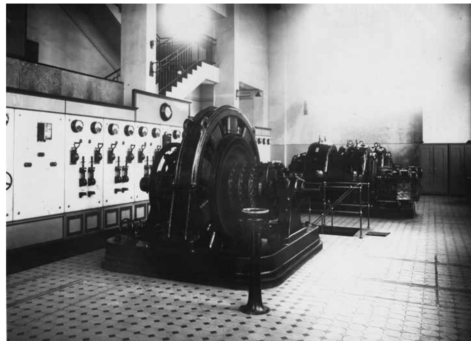
Pohled na vybavení prvorepublikové měnírny Teslova. Zařízení bylo vážně poškozeno při náletu v roce 1945. Sběrka: Archiv DPP
