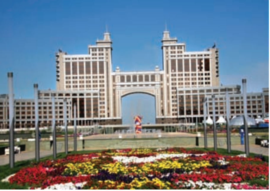
Fotoğraf 3.17 Kazmunaygaz Binası
