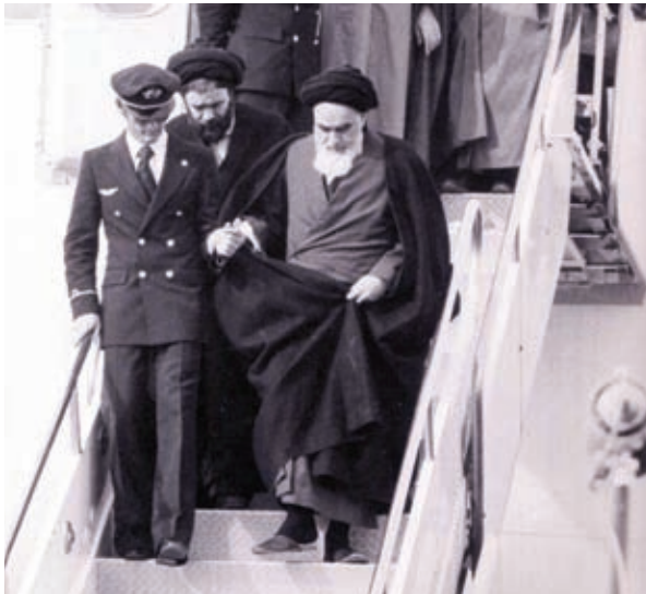
Xomeyninin Fransa polisinin müşayiəti ilə İrana qayıtması
