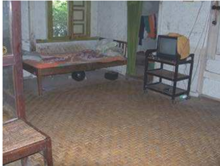
Gambar 21. Lantai Bambu ( talapuh ) Rumah Tradisional Sunda (Sumber: dokumentasi penulis, 2006)
