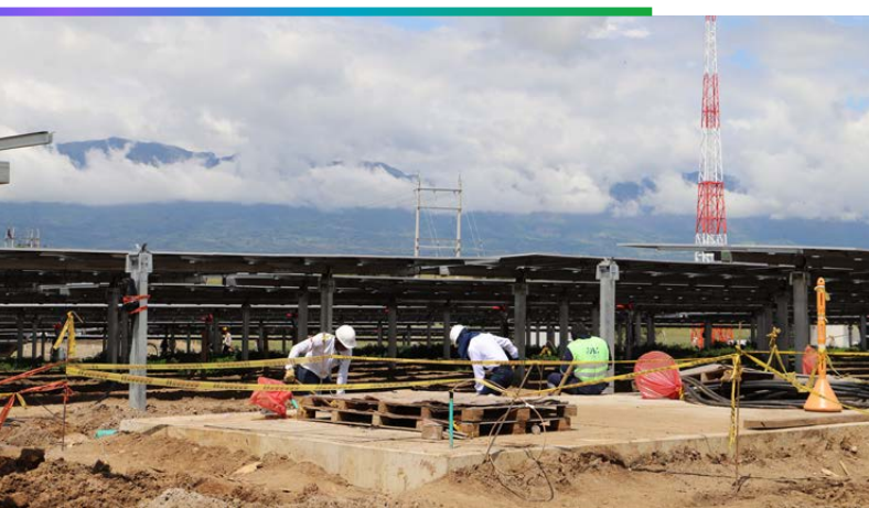
Construcción Parque Solar Brisas
