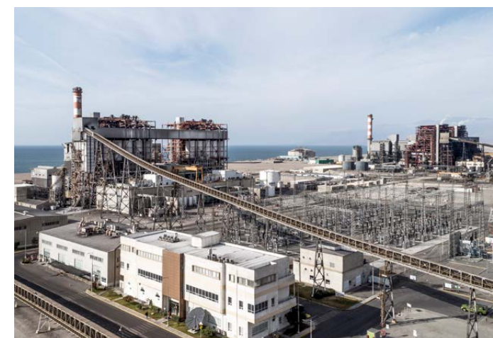
Centrales Angamos y Cochrane
