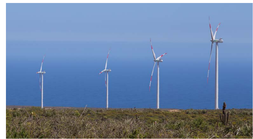
Parque Eólico Los Cururos
