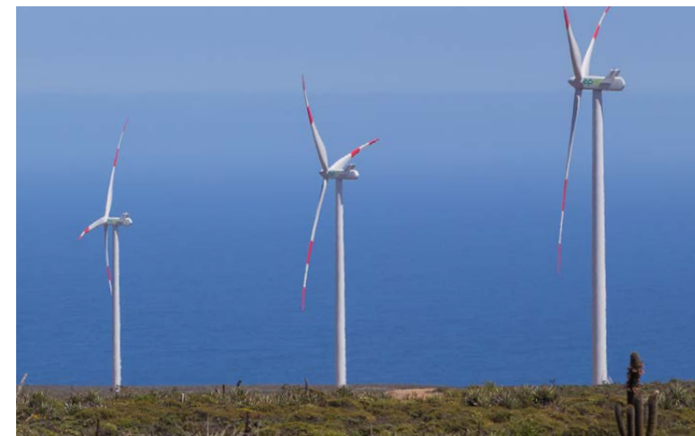
Parque Eólico Los Cururos
