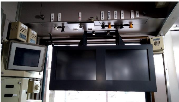
【運転室カメラ表示モニタ】
