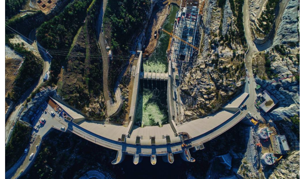
Daivões concrete arch-dam, ALTO TÂMEGA / Portugal
