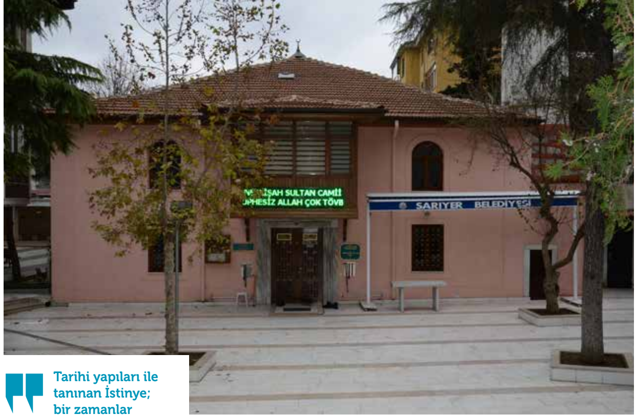
Neslişah Sultan Camii
