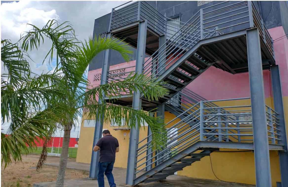
Foto 01 – Início dos trabalhos (Acesso às cabines)
