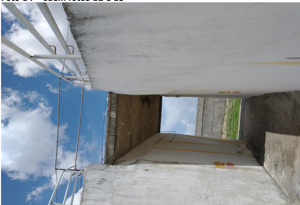
Foto 15 – Parede apresenta desnível devido ao recalque
