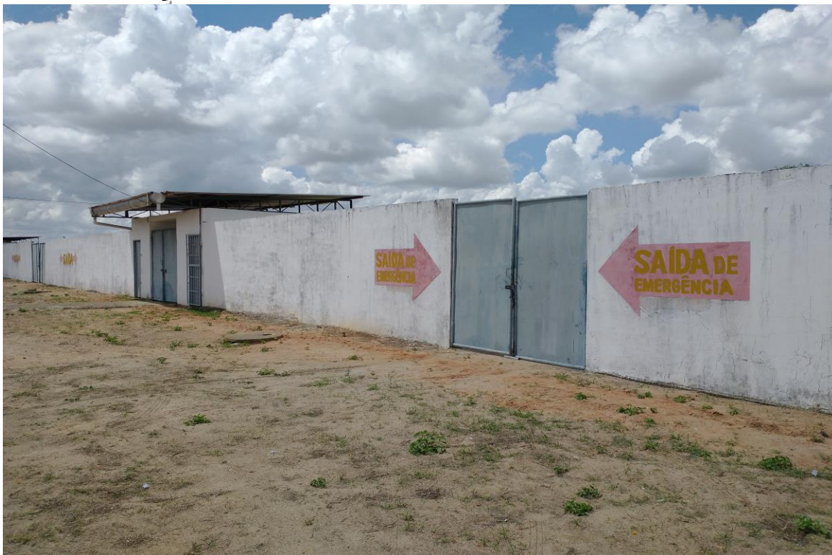
Foto 05 – Saídas de emergência sinalizadas
