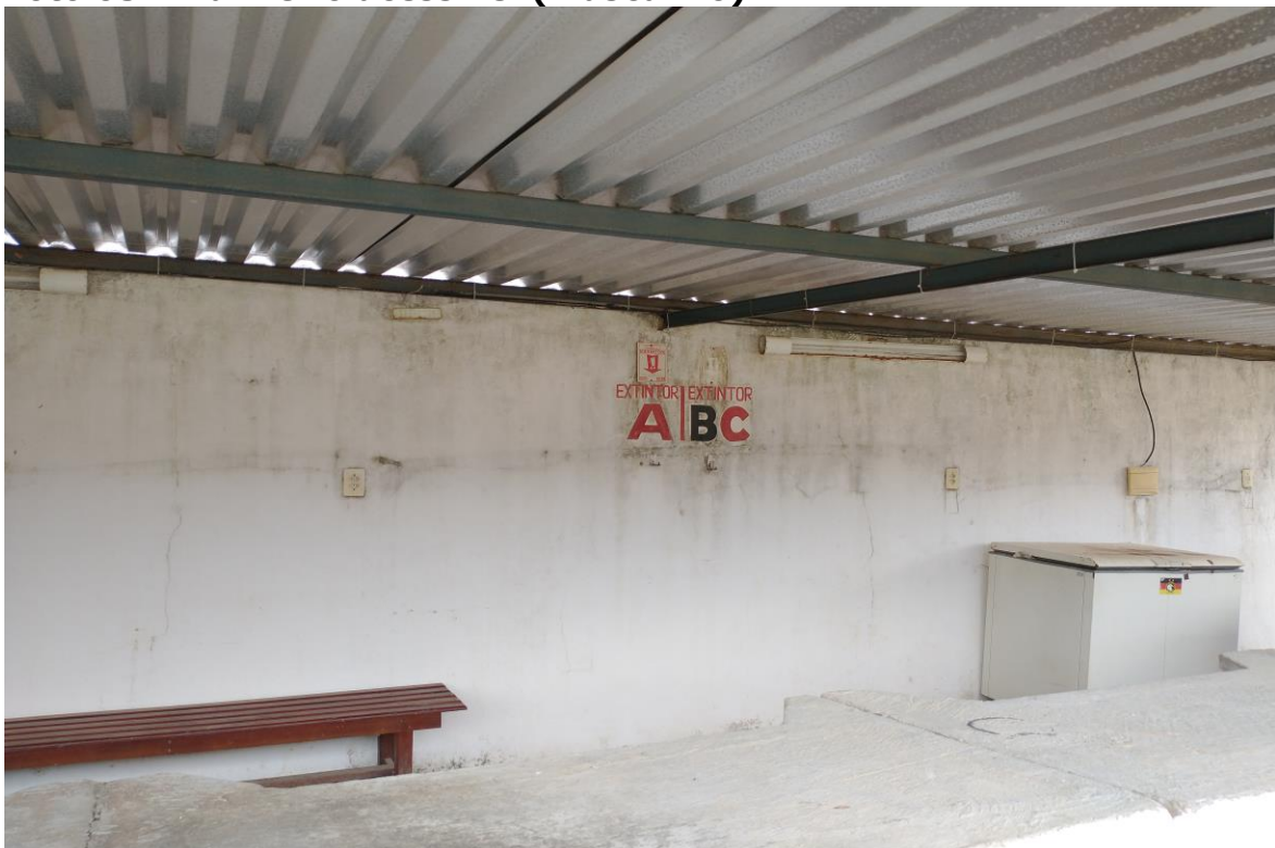
Foto 04 – Ausência de extintores neste setor
