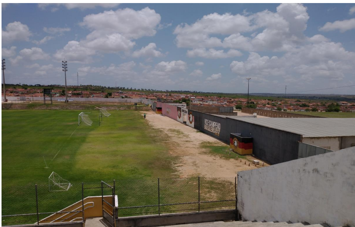
Foto 11 – Vista do gramado e acesso aos vestiários.
