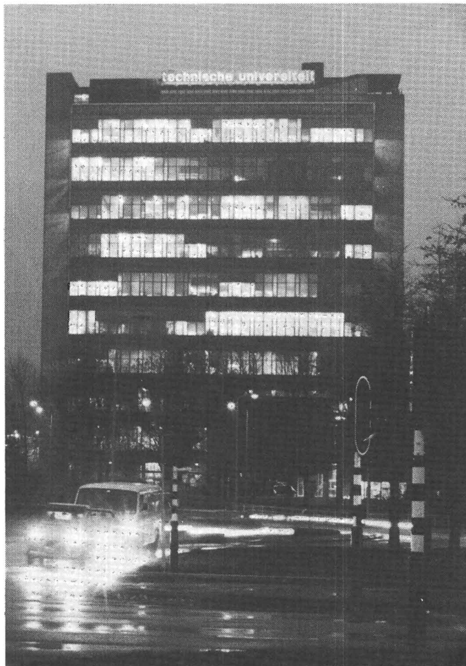
Het gebouw van de faculteit Scheikundige Technologie op het TUE-complex.
