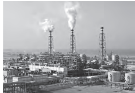
サウジアラビアRabigh IWSP火力発電所全景
