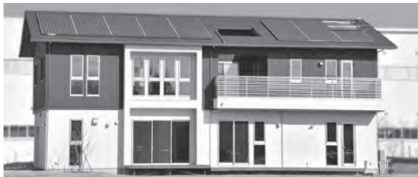
大船スマートハウスの外観
