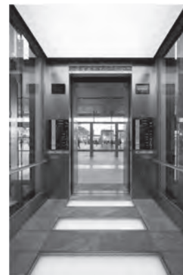
かご室床のLED照明
